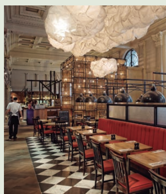
Restauracja Burger & Lobster. Bath, Wielka Brytania. Pompa ciepła powietrze-woda Aquarea została zainstalowana w nowo otwartej luksusowej restauracji Burger & Lobster w Bath. Octagon Chapel, duży zabytkowy budynek w centrum miasta, został przerobiony na restaurację, a system Aquarea firmy Panasonic zapewnił wszechstronne, energooszczędne i dyskretne rozwiązanie w zakresie ogrzewania i chłodzenia.
