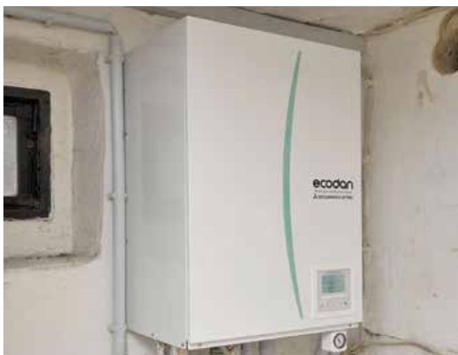
Moduł wewnętrzny bez wbudowanego zasobnika CWU zapewnia efektywne przeniesienie energii z czynnika chłodniczego do wody grzewczej
